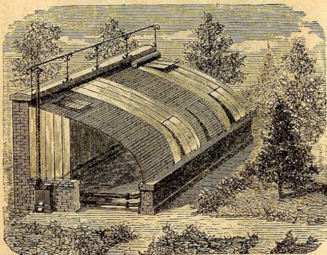
*Vue du chauffage d'une serre, le service se faisant de l'extérieur.*
